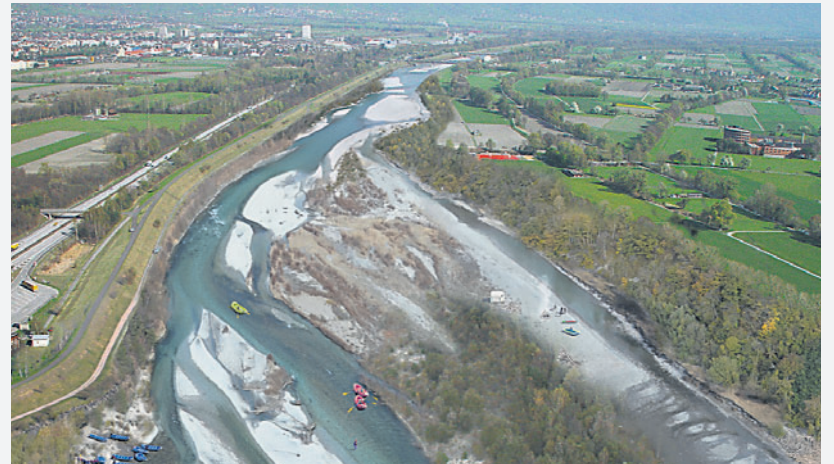
Der Rhein bei Vaduz aktuell (oben) und nach der Aufweitung (unten).
